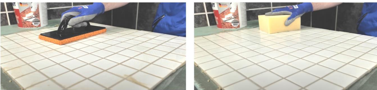
Рис. 41. Диагональными движениями шпателя убрать с поверхности плитки излишки затирки
