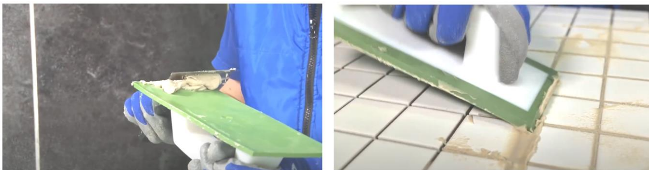
Рис. 39. Заполнение швов затиркой при помощи резинового шпателя
